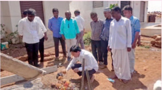
హద్దూర్‌లో సిసి రోడ్డు పనులను ప్రారంభిస్తున్న కాంగ్రెస్ నేత షరీఫ్
